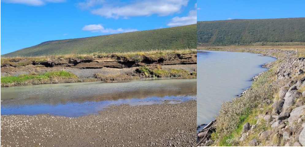
7. mynd. Austurbakki Skjálfandafljóts á fyrirhuguðu brúarstæði (vinstri mynd) og vörn gegn bakkabroti nokkur sem er þar nokkru neðar (hægri mynd).
